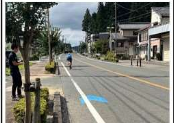
▲車道外側線上に矢羽根型路面標示
